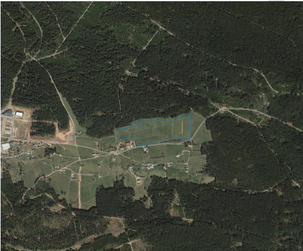
Abb. 2 Luftbild des Vorhabenstandortes (LUBW)
